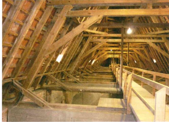
Bild 1. Dachstuhl der „Oberkirche“ in Cottbus, Bauzeit 15.-16. Jhd., Sparrendach mit liegendem Stuhl
